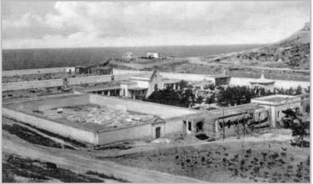
Cementerio de Melilla cuando se estaba construyendo el Panteón. Puede observarse el mismo sin cruz ni ángel, en la parte superior central de la foto.
