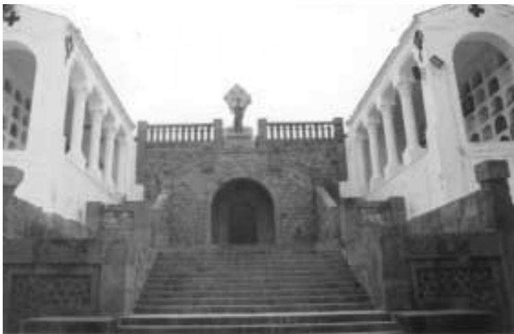
Acceso al Panteón. Puede observarse el blanqueado de las galerías a izquierda y derecha, ocultando la piedra natural parte del conjunto.
